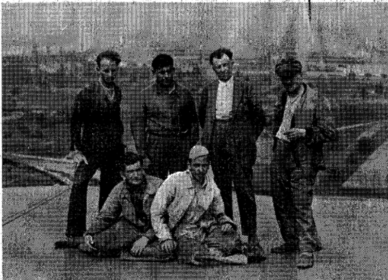
1931 auf dem Kleinhühner Gaskessel. RGO-Sekretär Bodenmann (stehend, 3. von links) überzeugt sich anlässlich einer Lohnbewegung der Malerequipe von den harten Arbeitsbedingungen beim Gaskesselbau. Photo Fritz Forter
